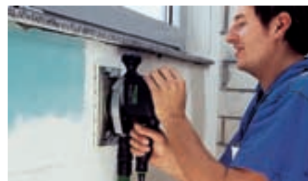
Auch an senkrechten Flächen arbeiten Sie ermüdungsarm.
