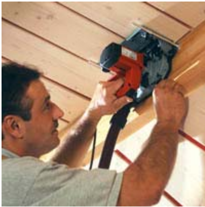
Kein Problem: Schattenfugen ab 13 mm Fugenbreite.
